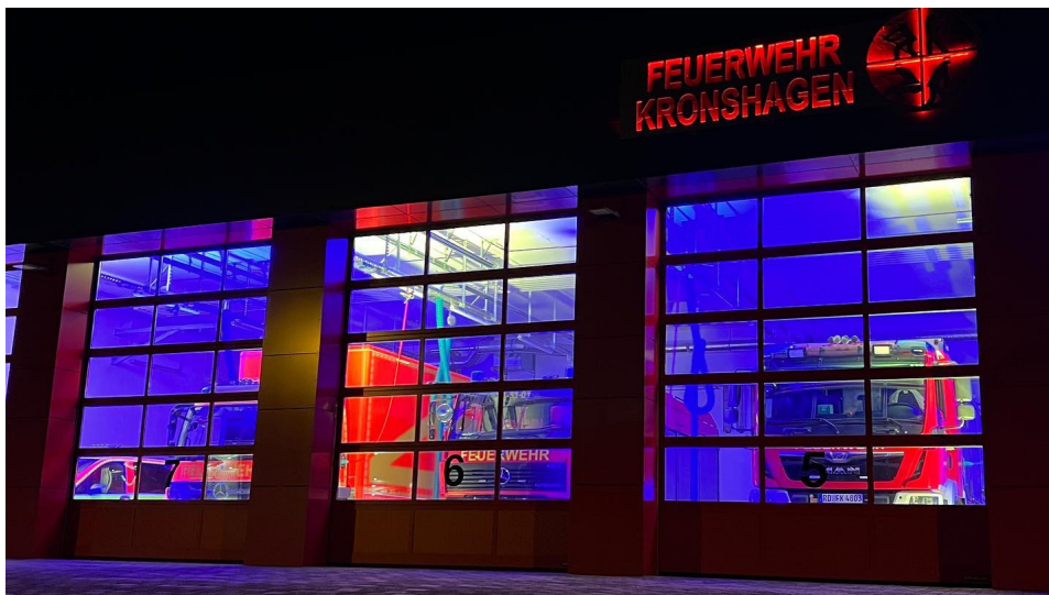
Ein Teil des Neubaus der Fahrzeughalle der FF Kronshagen. (Quelle: FF Kronshagen)
